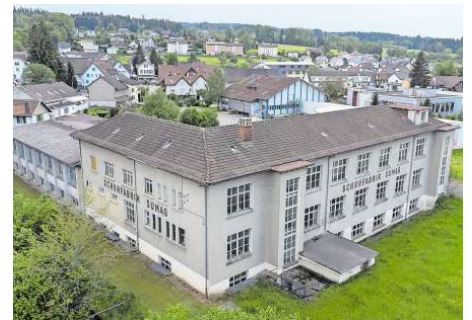
Das Gebäude der ehemaligen Schuhfabrik Sumag steht am nördlichen Dorfeingang von Märwil.
